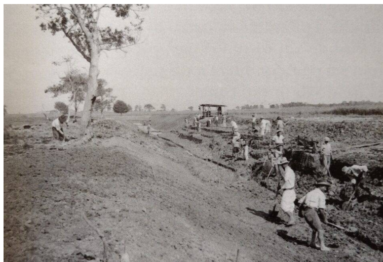
Scavo del canale perimetrale del Lago di Fogliano (foto tratta da: L. Ebanista, Ager Pomptinus I (Forma Italiae) , Roma
