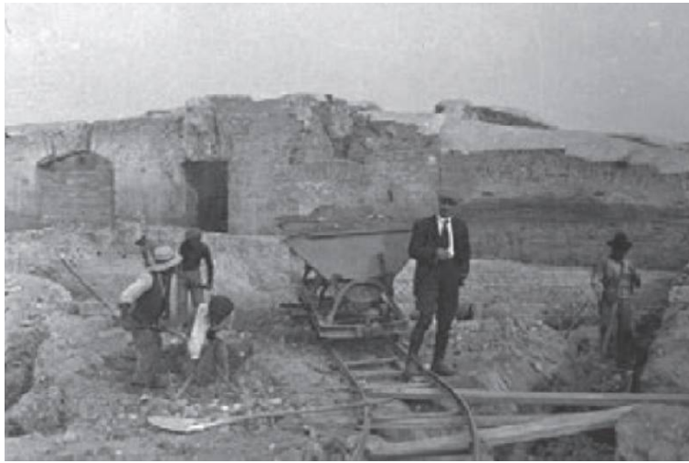
Scavo di via Fullonica con dettaglio della Decauville (foto tratta da: C. SORRENTINO, Archeologia in archivio. I fondi fotografici delle Soprintendenze e il caso di Ostia Antica , in Analysis archaeologica , 4 (2018), p. 241)
