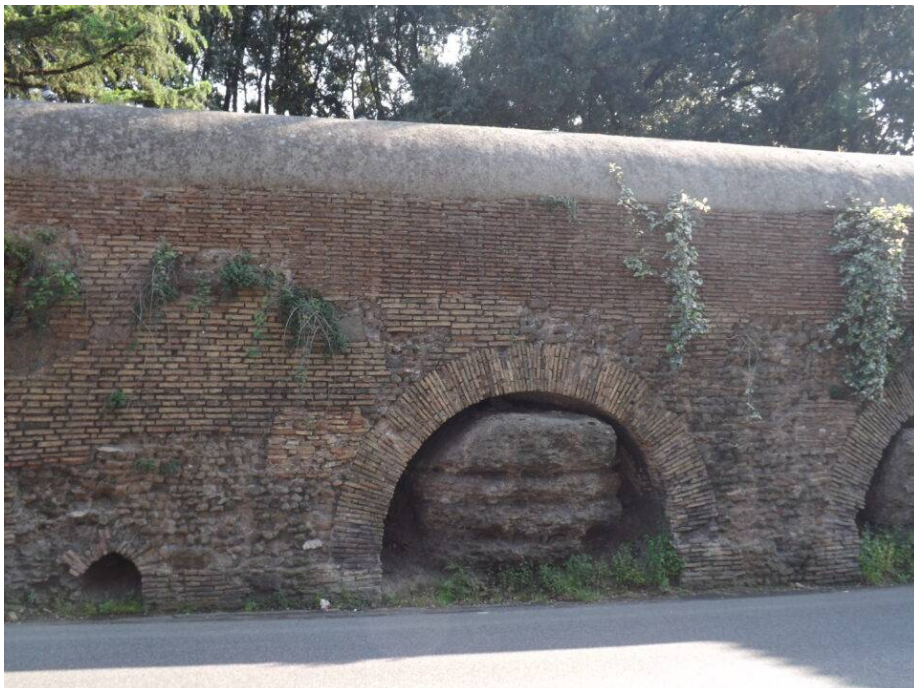
Arcate dell'acquedotto in prossimità dell'entrata di Villa Doria Pamphilj, civico n. 183 (foto di Cristina Cumbo)
