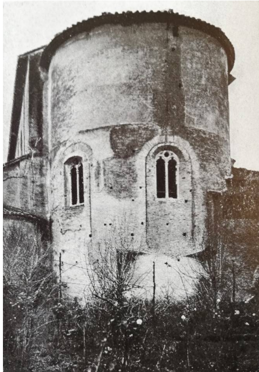
Roma, Basilica di Santa Sabina, esterno, abside. Si notino le bifore gotiche ricavate nelle finestre absidali (foto tratta da Muñoz 1938)
