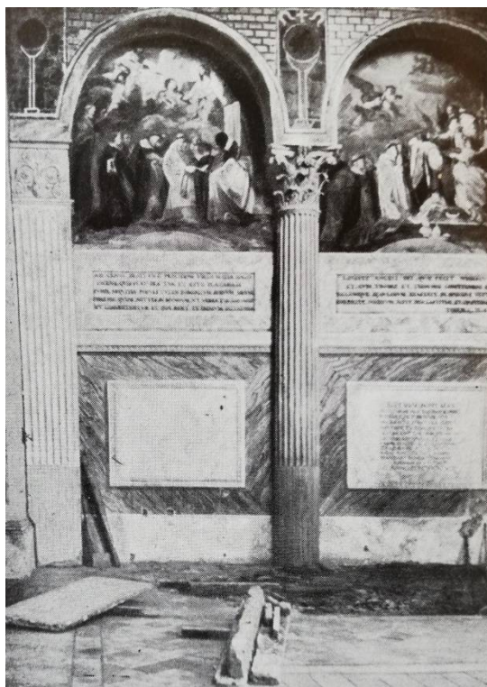
Roma, Basilica di Santa Sabina, interno. In questa foto si possono osservare le pitture ottocentesche eseguite sui muri di tamponamento delle arcate di destra della navata centrale (foto tratta da Muñoz 1938)
