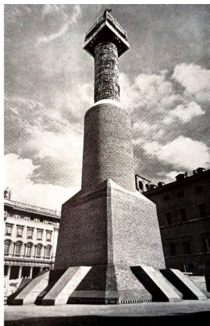
1. La Colonna Antonina al termine dei lavori di protezione antiaerea (foto tratta da: Direzione Generale delle Arti, La protezione del patrimonio artistico nazionale dalle offese della guerra aerea , Le Monnier, Firenze 1942)
