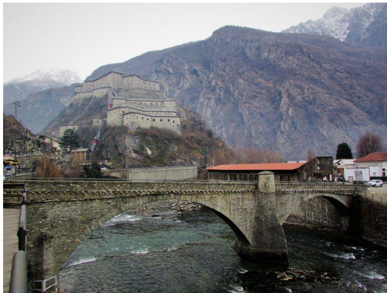
Il forte visto dal borgo (foto di Simona Pons)
