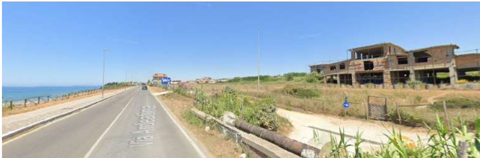
Cantiere lungo la Via Ardeatina (foto Google Maps)
