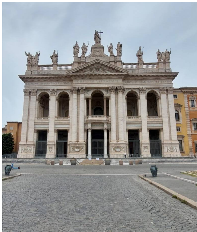
Roma, San Giovanni in Laterano, esterno: la facciata a seguito dei lavori dell'Alessandro Galilei (foto di Giulia Abbatiello)
